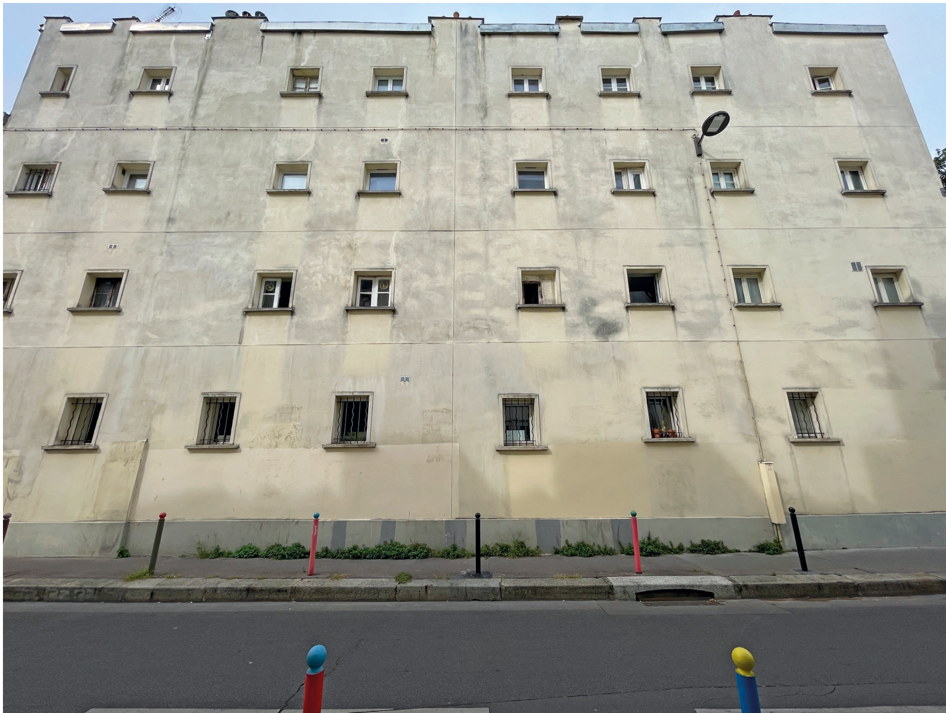
Là où l'immeuble tourne son dos à la rue - Where the building turns its back to the street • allée Verte, Paris
