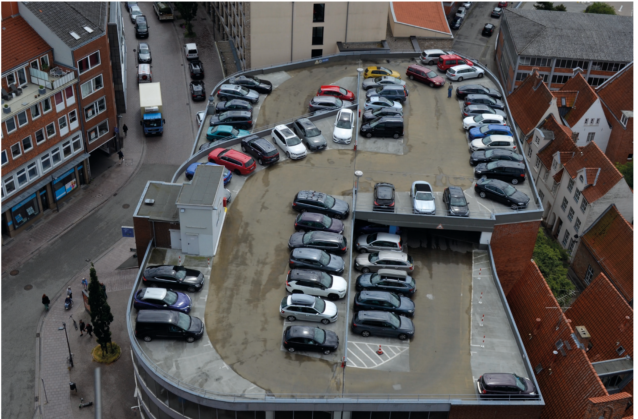
Un parc de stationnement gordien - A Gordian parking lot • Parkhaus Mitte, Schmiedestraße, Lübeck
